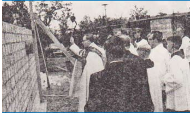
Der Grundstein wird eingemauert.
